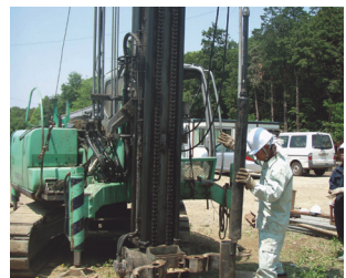
⊕α(1) 杭先端部モンケン落下
