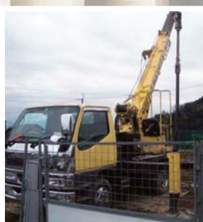
建柱車での施工
