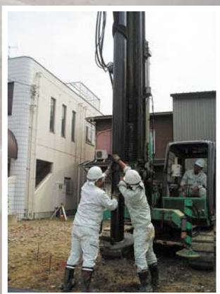
①杭の建て込み
